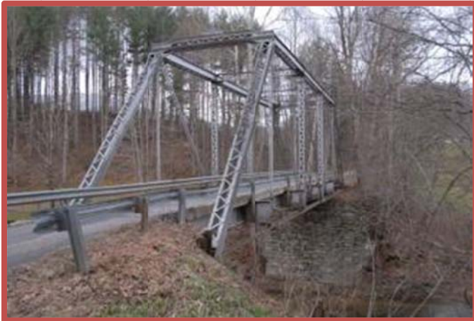
Photo 4: The ET&WNC Blevins Steel Truss thru bridge just north of Blevins
